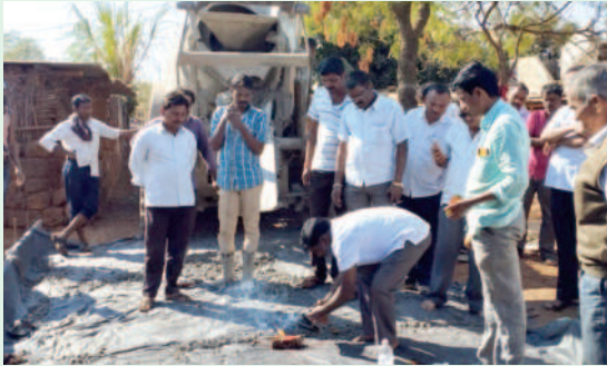
సిసి రోడ్డు పనులను ప్రారంభిస్తున్న సర్పంచ్ చంద్రపు
